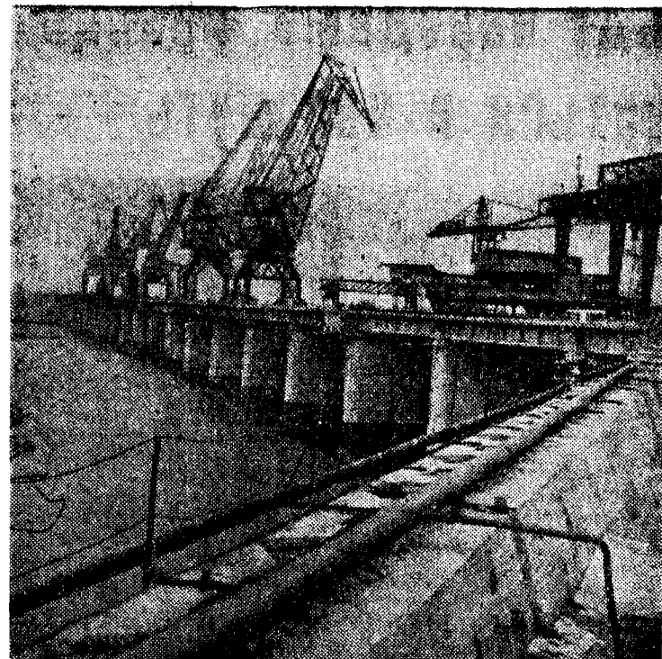
УКРАИНСКАЯ ССР. Кременчугская ГЭС — важная ступень в насаждении гидроэлектростанций на Днепре. Первые четыре ее агрегата еще в прошлом году начали давать ток. Сейчас монтируются пятый и шестой агрегаты. Строители решили пустить ГЭС на полную мощность к 43-й годовщине Великого Октября — на два года раньше установленного срока. НА СНИМКЕ: на одном из участков строительства Кременчугской ГЭС. Фото И. Селюченко. (Фотокроника ТАСС).
