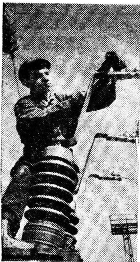
Горячие дни наступили для монтажников повышенной ТЭЦ в Магадане. Работающие здесь электромонтажники-высотники хабаровского треста «Дальэнергомонтаж» обзавелись специальной вышкой. НА СНИМКЕ: электромонтажник комсомолец Александр Федорев ведет установку масляного выключателя подстанции. Фото Ю. Муравина. (Фотохроника ТАСС).
