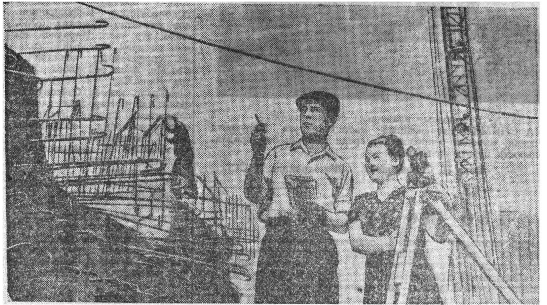
Тысячи молодых строителей работают на Волгодонстрое, показывая образцы высокопроизводительного труда. Так, на строительстве насосной станции Барваровского гидроузла старшим прорабом работает молодой специалист А. Былинкин. Возглавляемый им участок является передовым по выполнению графика укладки бетона.
